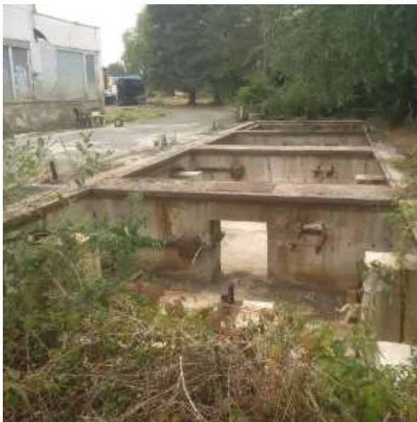
Abb. 5-2: Blick auf bauliche Überreste der alten Waagen-Brücken
