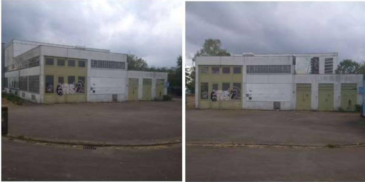
Abb. 5-1: Blick auf die versiegelten Flächen um die Halle
